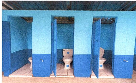
Foto 6: Mantenimiento a puertas metalica existente retiro de óxido, suciedad y pintura deteriorada; incluye cepillado, lijado y aplicación de pintura.
