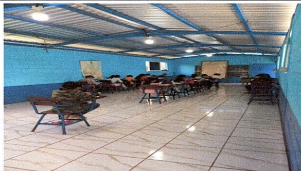
Foto 3: Sustitución de piso ceramico por piso ceramico.
