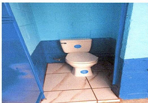
Foto 5: Sustitución de accesorios de sanitarios, incluye accesorios internos, externos, tapa y asiento.
