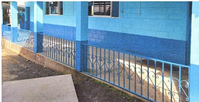
Foto 7. Mantenimiento a barandas metálicos , icluye lijado y pintura.
