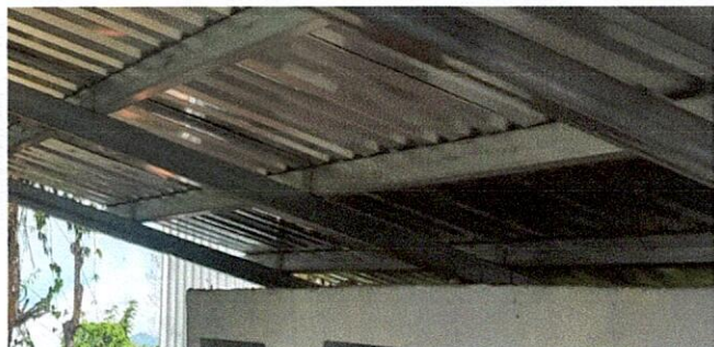
Foto1: Sustitución de cubierta de techo con lámina galvanizada, Tipo de lámina: troquelada calibre : 26, incluye fijaciones y sellado en traslapes.
