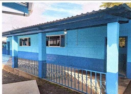
Foto 4: Preparación de la superficie y aplicación de pintura a dos manos, en paredes de interiores y exteriores del establecimiento.
